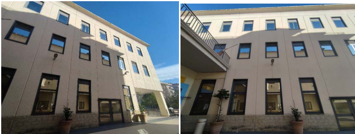
Parete verticale esterna lato sud
