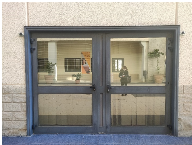
Finestra parete lato sud
