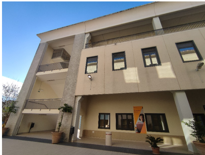
Parete verticale esterna lato nord
